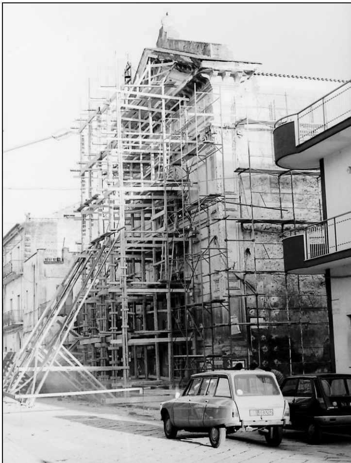
Puntellatura e armatura in legno predisposta dall'ing. Angelo Spizuoco, il giorno immediatamente dopo il Sisma del 23-11-1980, per lavori di messa in sicurezza e riparazione della parrocchia di San Vitaliano (NA) progettati e diretti dal medesimo.
