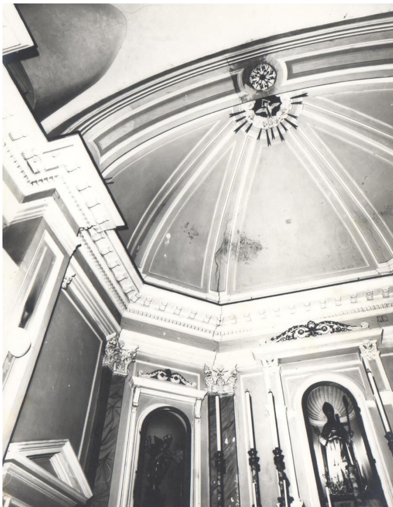
Lesione longitudinale nella cupola della Parrocchia di San Vitaliano (NA) – A. Spizuoco 1981
