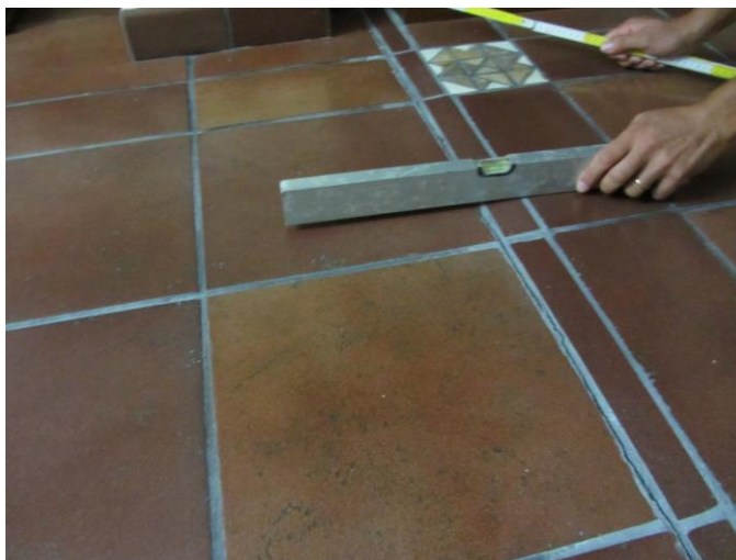
Controllo speditivo della orizzontalità dei solai - A. Spizuoco 2013.
