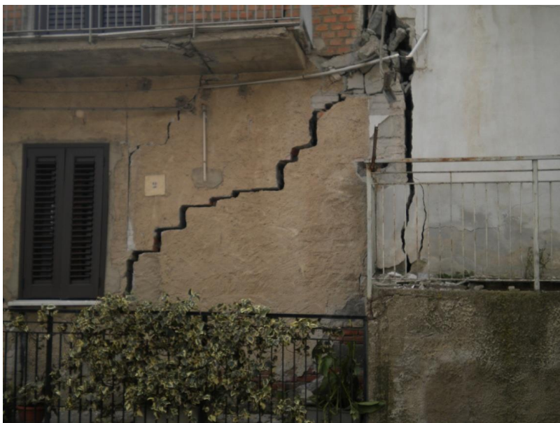
Frattura per cedimento fondale - A. Spizuoco 2010
