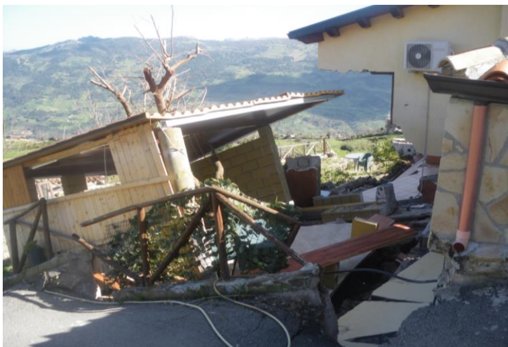
Fabbricato dissestato in area di frana a San Fratello (Me) A. Spizuoco 2010
