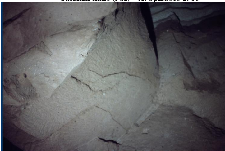
Zona intensamente fratturata in prossimità di pozzo di areazione
