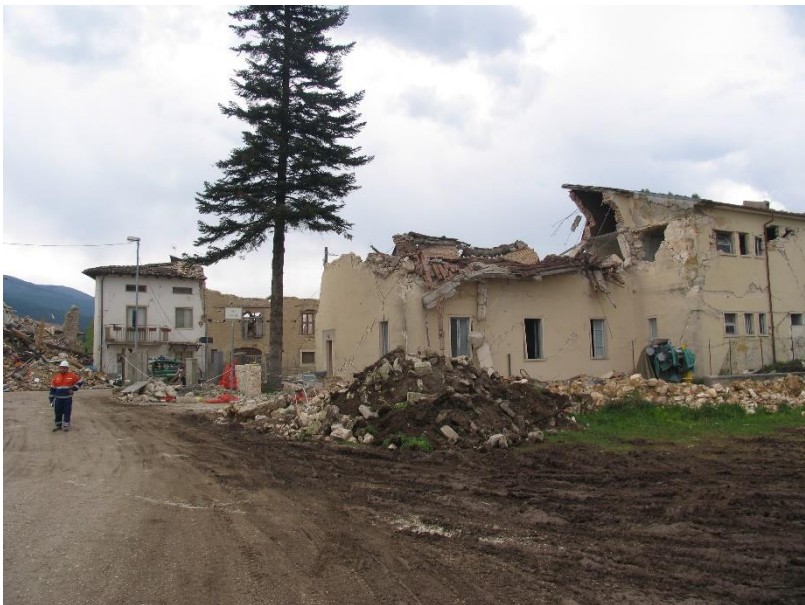
“Catenaria” per effetto del sisma aprile 2009 Onna (AQ). A. Spizuoco 2009
