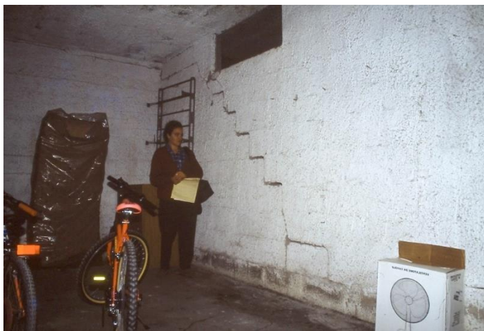
Visione globale della frattura - A. Spizuoco 2000
