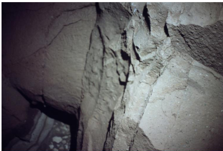
Zona di intensa fratturazione per stress geomeccanico
