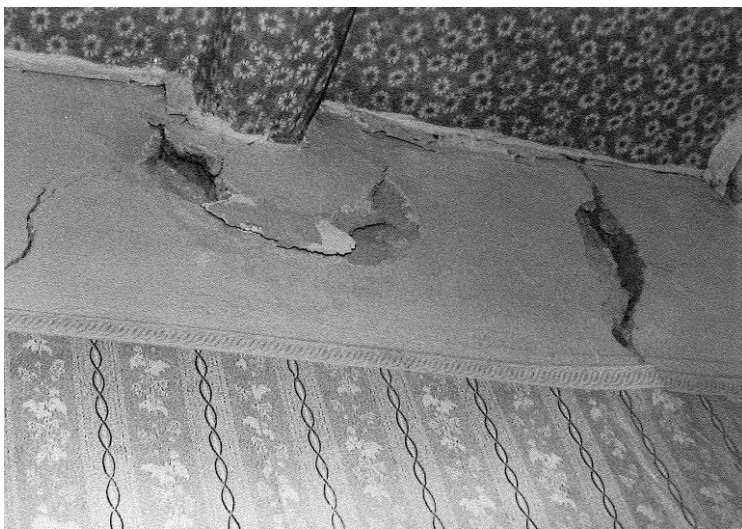
Tentativo di sfilamento dagli appoggi travi sottostanti.
