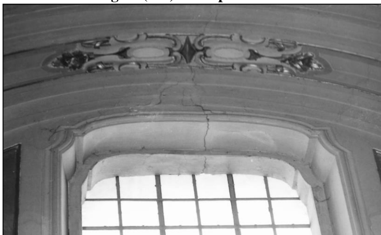
Lesioni in chiave di un'arcata della Chiesa Madre, Afragola (NA) – A. Spizuoco 1981
