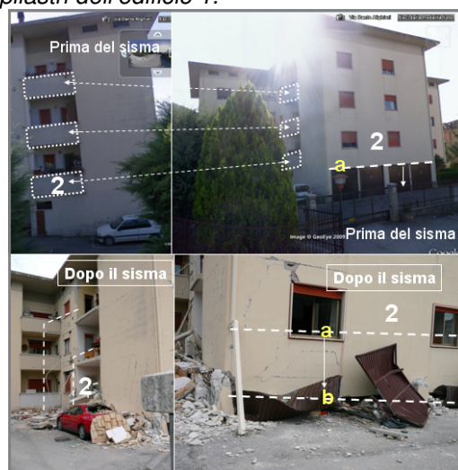
Fig.16: Zona dell'edificio 2 di Pettino. Effetti della forte amplificazione sismica connessa ad oscillazioni orizzontali orientate SW-NE e NW-SE. Le foto in alto illustrano l'edificio prima del sisma e quelle in basso dopo l'evento. In alto a destra la linea (a) bianca tratteggiata evidenzia l'abbassamento dell'edificio in seguito al tranciamento dei pilastri (b) avvenuto per effetto di oscillazioni orizzontali orientate SW-NE. La foto in basso a sinistra evidenzia il distacco dei parapetti dei balconi sottoposti ad oscillazioni orientate NW-SE.
