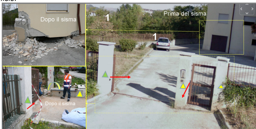
Figura 15: Zona dell'edificio 1 di Pettino. Effetti della forte amplificazione sismica connessa ad oscillazioni orizzontali orientate SW-NE e NW-SE. I riquadri indicati nell'immagine a destra (prima del sisma) con linea gialla continua e tratteggiata individuano le aree rappresentate nelle foto a sinistra dopo il sisma. Il pilastro del cancello indicato con il triangolino verde è stato spostato da SW a NE mentre i pilastri individuati con il triangolino giallo sono stati abbattuti da NW a SE dalle sollecitazioni sismiche che hanno originato le fratture del suolo e il tranciamento dei pilastri dell'edificio 1.
