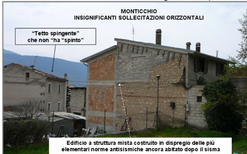
Figura 10: Zona di Monticchio centro abitato distante circa 1300 metri da Onna. Gli edifici ubicati in parte su substrato carbonatico compatto e in parte su copertura detritica compatta con caratteristiche geotecniche simili a quelle del substrato sono stati sottoposti a insignificanti sollecitazioni orizzontali come evidenziato dai lievi danni riscontrabili anche dalle due foto in alto della figura 11.
